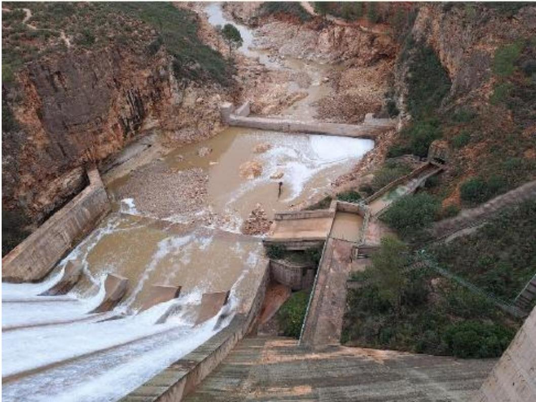
*Vista general de la zona aguas abajo de la Presa de Forata. Se aprecian los daños en el contraazud, el cuenco amortiguador, la ladera en la margen izquierda del propio cuenco y la ladera frente al azud, por la que discurre en túnel del primer tramo del Canal del Magro.*
