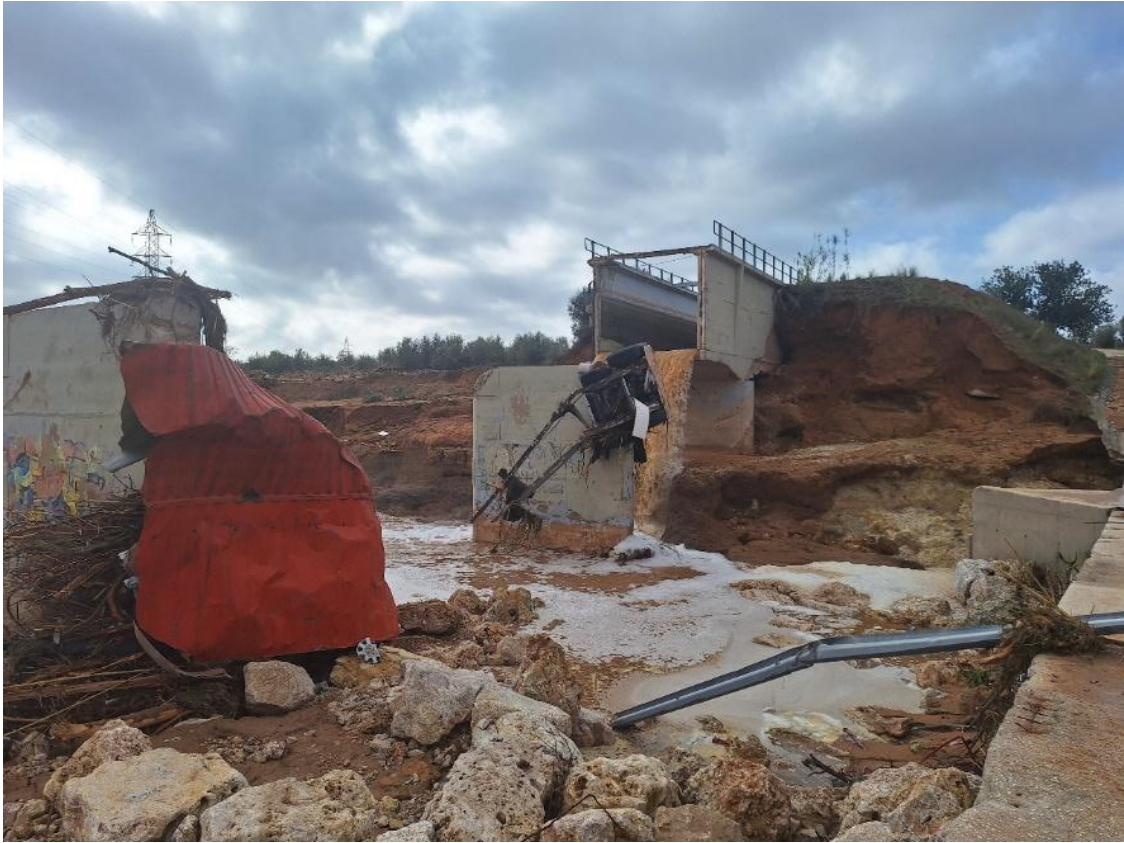
Rotura del acueducto de la Horteta
