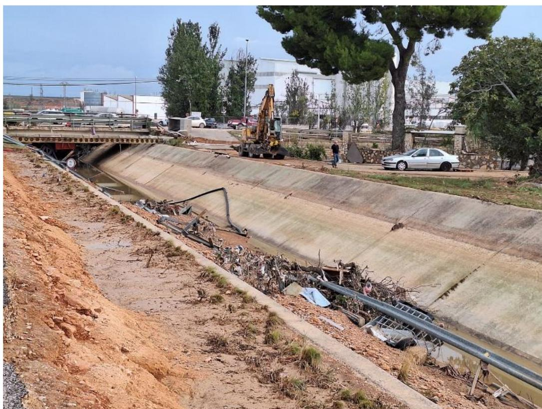
*-Rotura de bionda y obstrucción del canal-*
