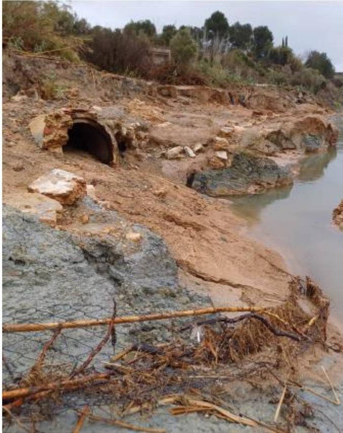
*Aspecto de la obra de toma. Se aprecia la disminución de la cota del río que impide el funcionamiento del bombeo.*
